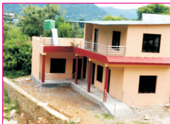
वडा नं. १० को वडा कार्यालय भवन
