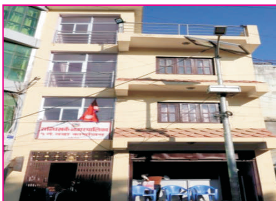
वडा नं. १ को वडा कार्यालय भवन
